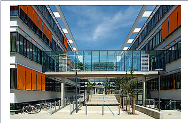
Lehrgebäude am Universitätsklinikum Halle (Saale)
