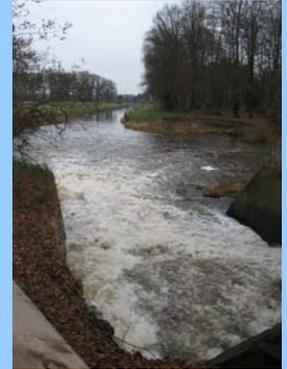
Bild 2: Kolkauströmung hinter Tosbecken [NLWKN, 2008]
