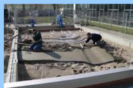
Bild 11: Herstellung der Geländeoberfläche mittels Estrich
